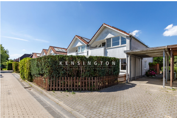
Haus Rückseite + Carport
